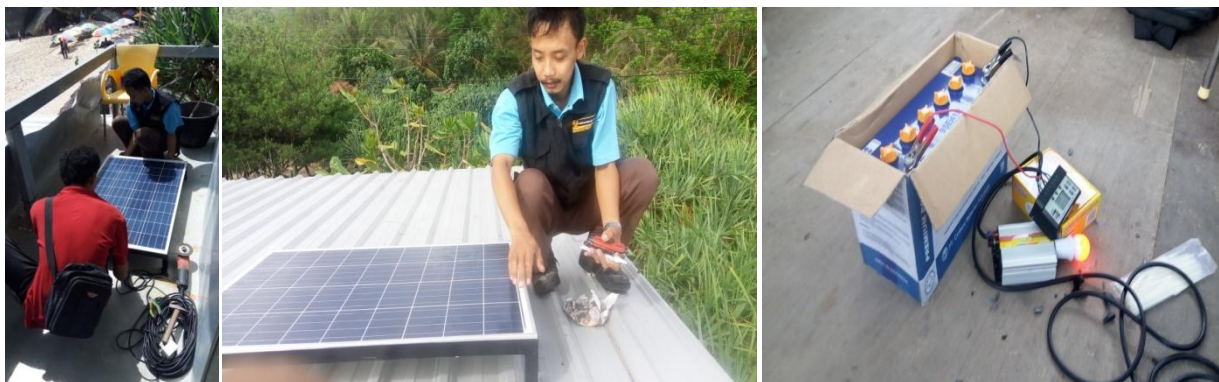
Foto 9. Setting Panel Surya sebagai Backup Catu Daya untuk Prototipe Aplikasi SBMS
