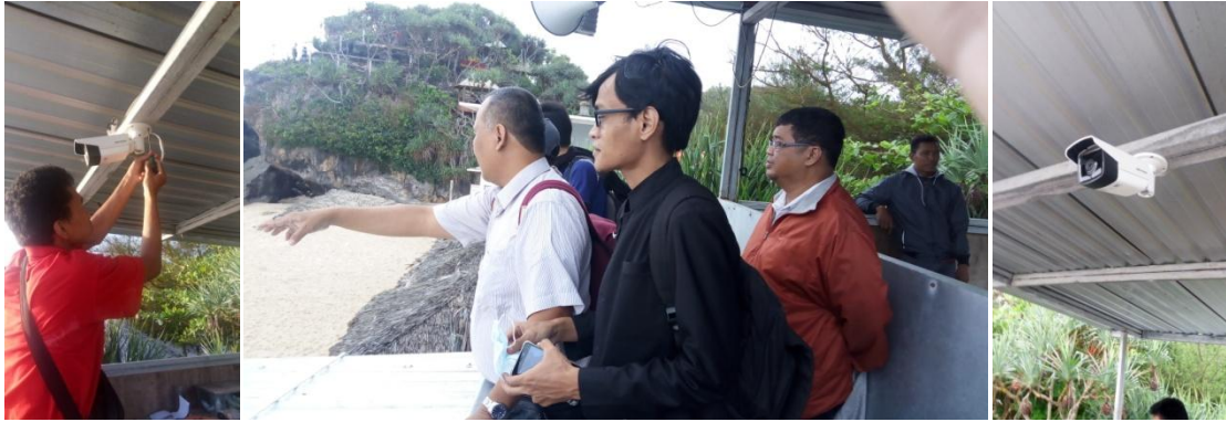
Foto 10. Setting Sistem CCTV dan Mengarahkan ke Target obyek untuk Prototipe Aplikasi SBMS
