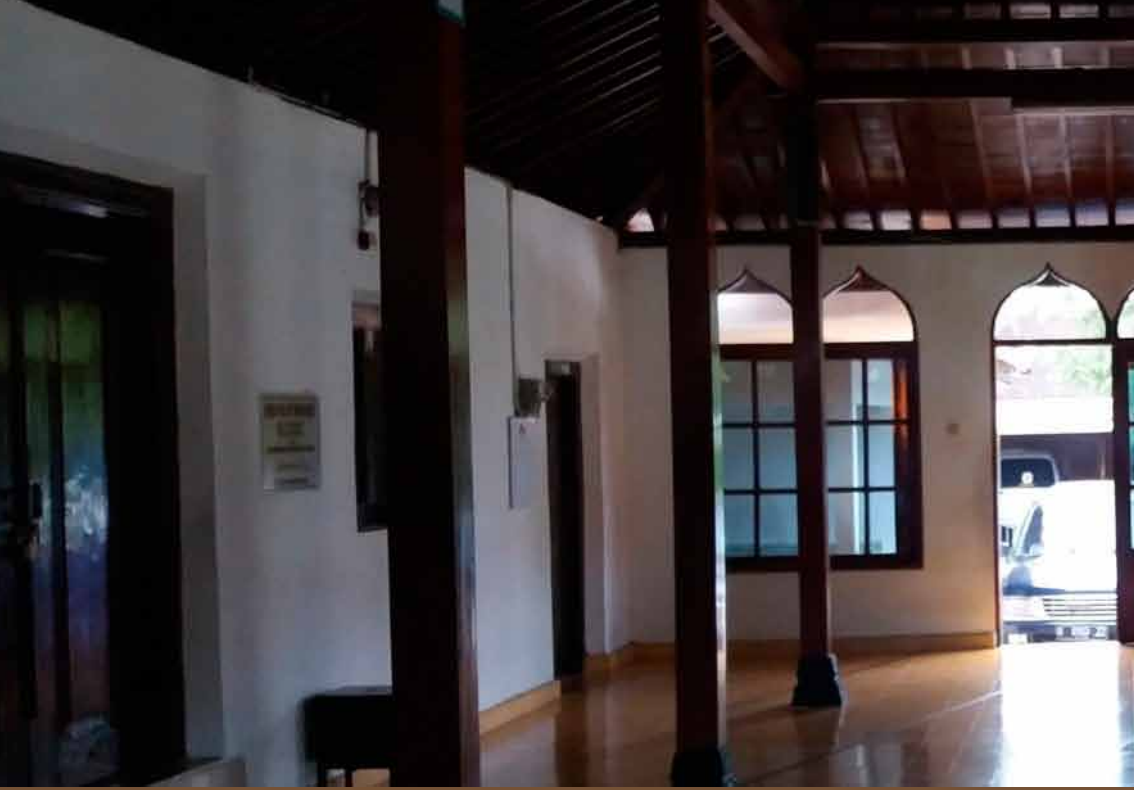
Gambar 4-3 : Interior bangunan serambi masjid Sumber : Survey lapangan 2017
