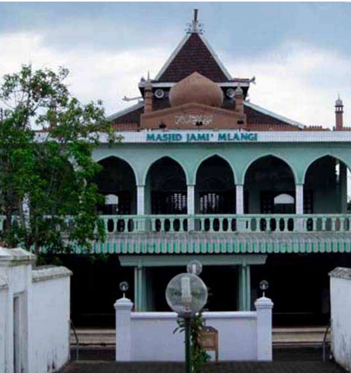
Gambar 3-1 : Masjid pathok negoro mlangi (sebelum ada pemugaran), sumber http://merahputih.com/post/read/jalan-jalan-religi-ke-empat-masjid-pathok-negoro-di-yogyakarta
