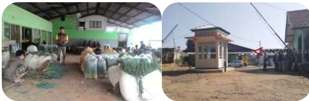
Gambar 3.19. Kondisi STA Cigombong di Kabupaten Cianjur
