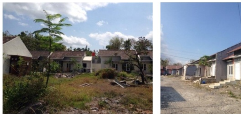
Gambar 4. 4 Sarana ekonomi di perumahan skala menengah ke bawah yang terbengkalai dan pembangunan jalan di perumahan yang tidak berkualitas. 21
