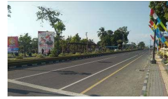
Gambar 23. Kondisi Jalan Jenderal Sudirman pada Tahun 2019
