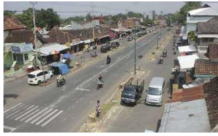
Gambar 21. Kondisi Jalan Jenderal Sudirman pada Tahun 2017
