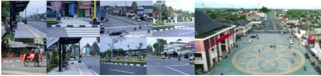
Gambar 2. Kondisi Jalan Jenderal Sudirman setelah renovasi Sumber : https://kusanantokarsan.com (diakses Agustus 2019)
