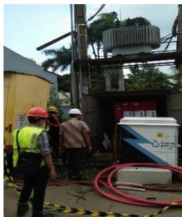
Gambar 12. Pekerjaan Penggantian Trafo Portal Rawan Gangguan
