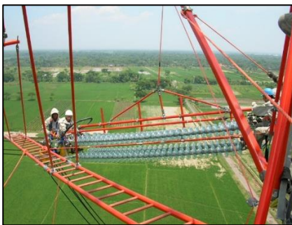
Gambar 2.3: PDKB Tegangan Tinggi
